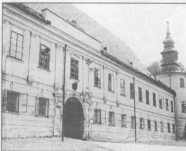
Stav v roce 1979 před zřícením části střechy.
