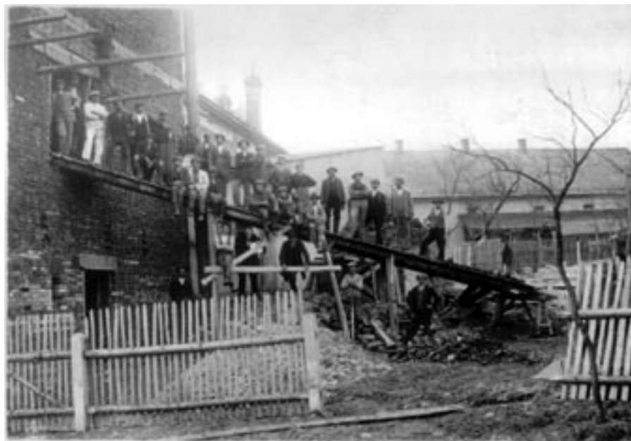
Stavba jeviště sokolovny v roce 1930
