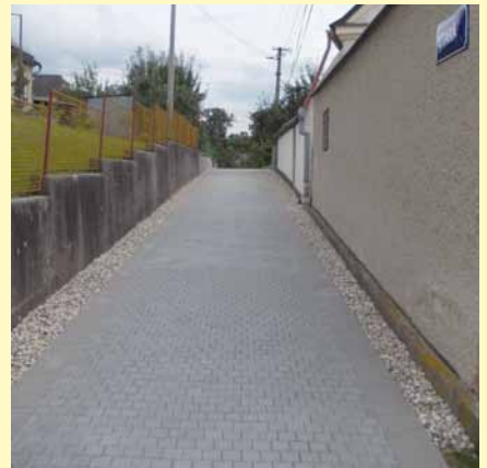
Dlouho neopravená ulice Stará dostala nový povrch – asfalt a v závěrečném úseku zámkovou dlažbu
